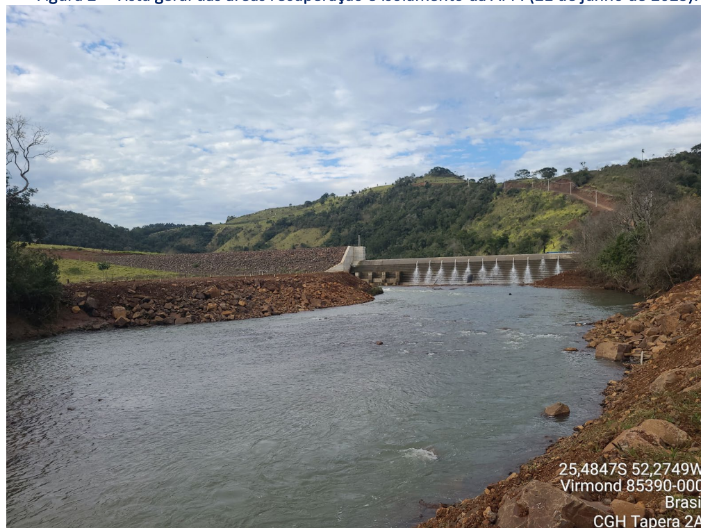
Figura 3- Vista geral das áreas recuperação e isolamento da APP. (21 de junho de 2023)
