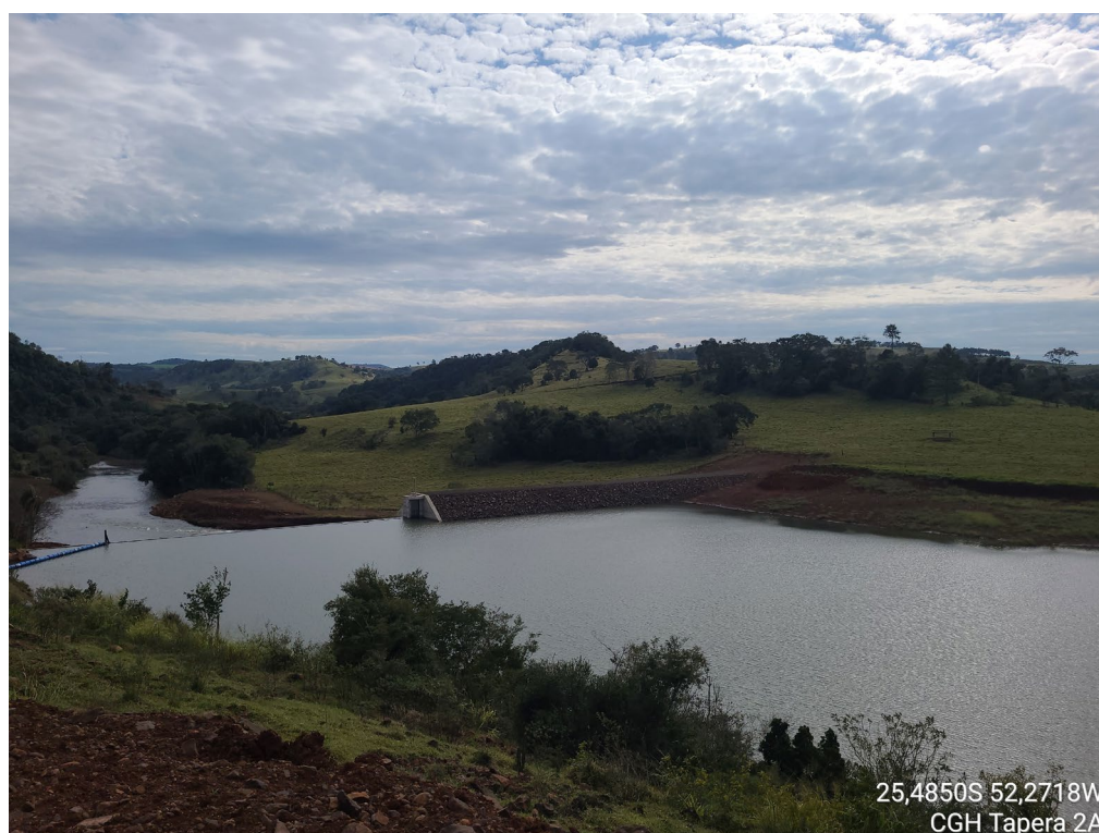
Figura 5- Vista da área de recuperação em andamento. (21 de junho de 2023).
