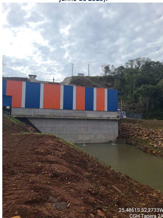
Figura 13- Acompanhamento da projeção de gramíneas. (21 de junho de 2023).
