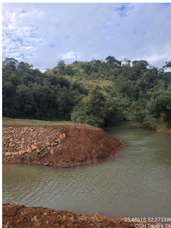
Figura 12- Vista da área de recomposição dos taludes. (21 de junho de 2023).
