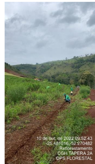
Figura 21 - Operadores trabalhando na linha de plantio
