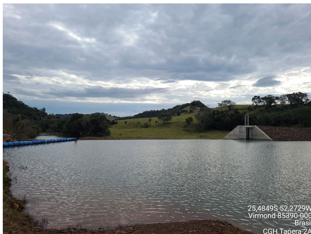
Figura 2 – Vista geral das áreas recuperação e isolamento da APP. (21 de junho de 2023).
